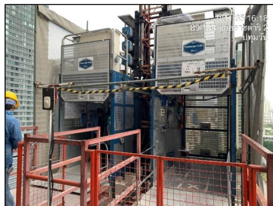
รูปที่ 2-46 ลิฟต์ขนส่งวัสดุก่อสร้าง
